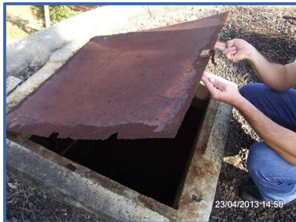
Imagem 36: Tampa da abertura de inspeção reservatório R 01.
