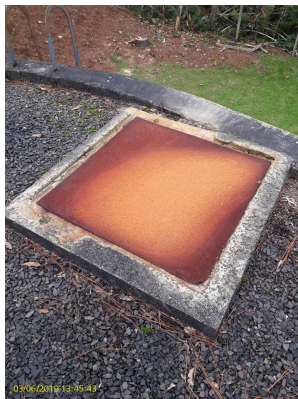
Foto 40 - Tampa de inspeção
