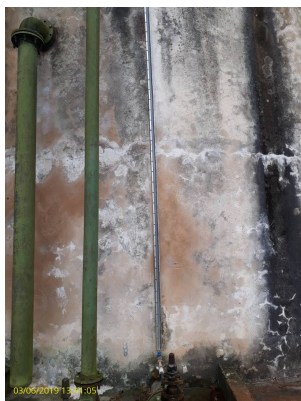
Foto 41 - Mangueira de nível
