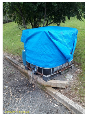
Foto 25 - Depósito de PAC
