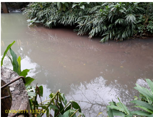
Foto 8 - Barragem de captação
