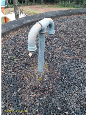
Foto 44 - Duto de ventilação
