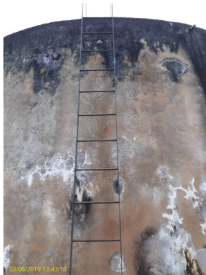
Foto 45 - Escada de acesso
